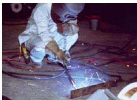
＜写真 2-2 アーク溶接・溶断作業＞ (提供：川本俊弘)
