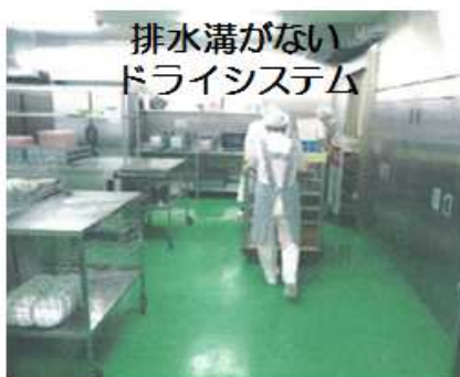
厨房における滑り止めの例
