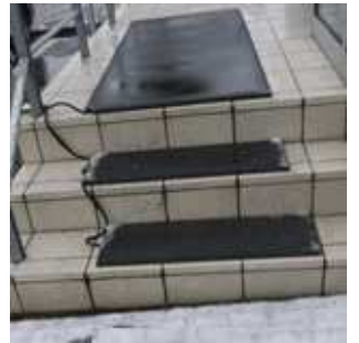
< ヒートマットの設置例 >
