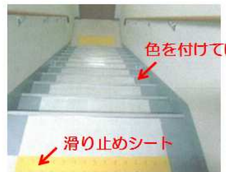
階段の踏み外し防止の例
