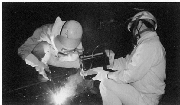
溶接場での粉じん測定風景
