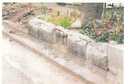
横筋が錆びて体積膨張し、内部からブロックを破壊していたとみられる倒壊事例
