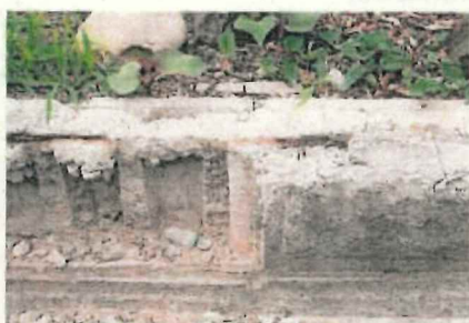
横筋が錆びて体積膨張し、内部からブロックを破壊していたとみられる倒壊事例
