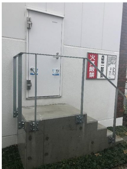
■ 塀に設けた防水扉
