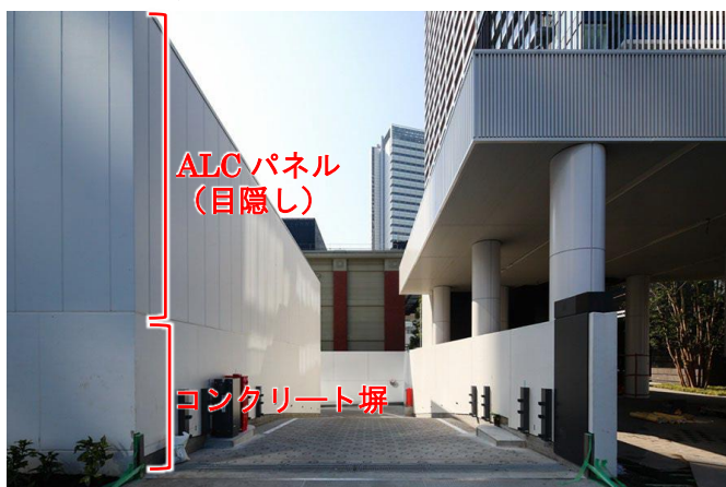
■ 電気設備周囲の塀
