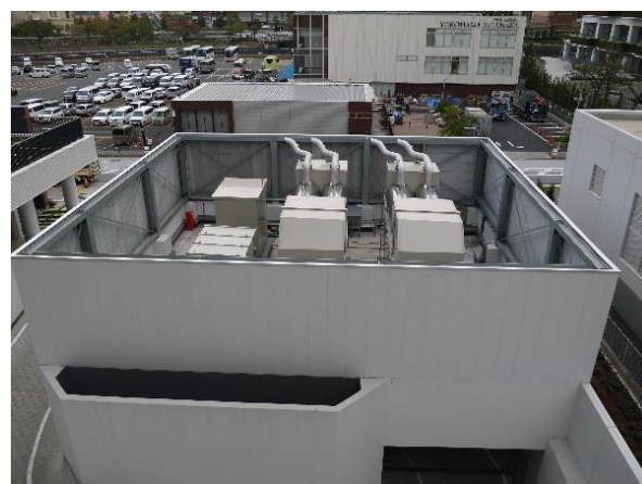
■ 電気設備の見下ろし
