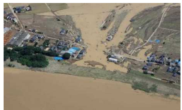
堤防決壊による家屋の流失(鬼怒川)
