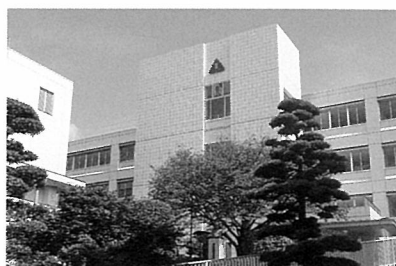
●附設高等学校・中学校施設設備整備事業
