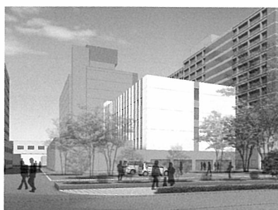
●病院北館(総合複合棟・放射線腫瘍センター)新築事業
